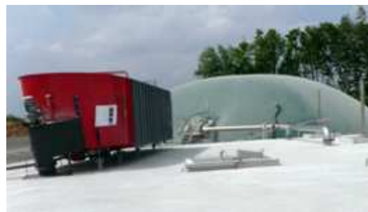
Vues de l'installation (crédit photo : ADEME)
